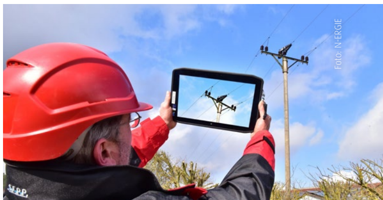
Mobile Instandhaltung im Netzbetrieb – Netzmonteur beim 20-Kv-Streckengang mit dem Tablet.
